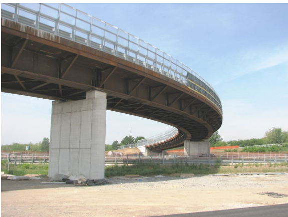
Autostrada Pedemontana Lombarda, Italia
